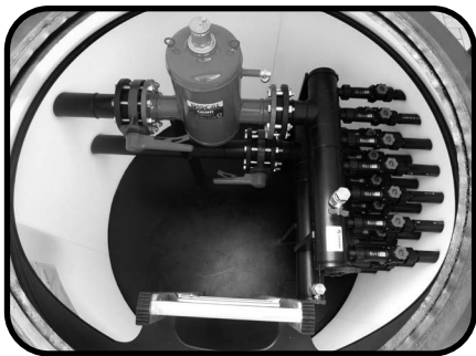
Verteilerschacht mit Mikroblasenabscheider
